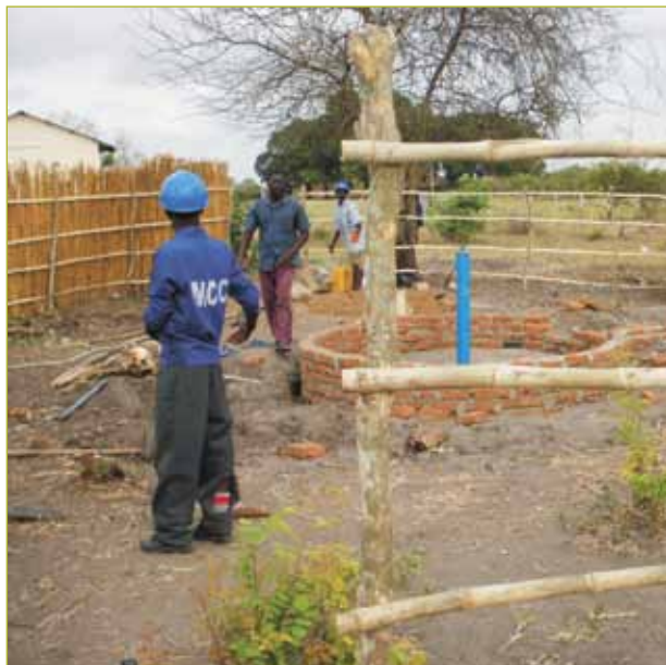
A sinistra: messa in sicurezza di un pozzo nel bairro di Nhamomba.
